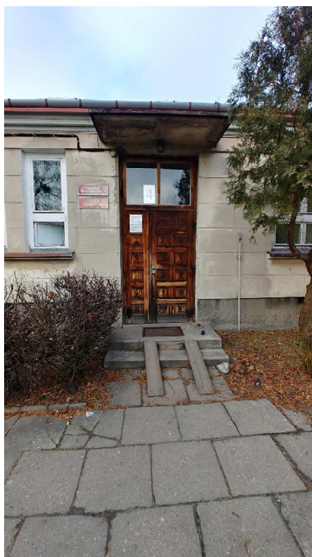
Fot. 3 Widok na schody i drzwi wejściowe do Poradni neurologicznej
