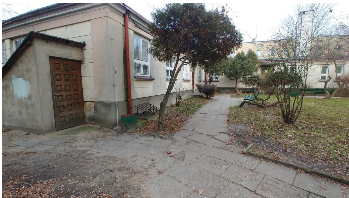
Fot. 2 - Widok budynku Poradni neurologicznej oraz chodnika przy budynku
