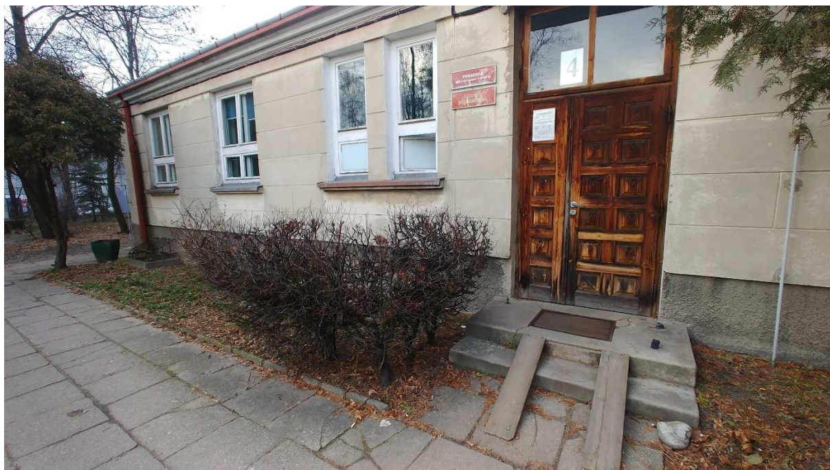
Fot. 1 - Widok wejścia do budynku Poradni neurologicznej
